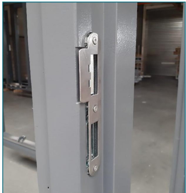
Figuur 15. Sluitplaat op onderleggingen. Door de ringen te verwijderen ontstaat meer ruimte voor de deur
